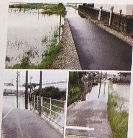
▲排水ポンプの故障による浸水状況
